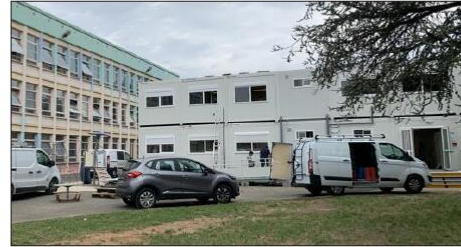
Visite de travaux fusion Olympe de Gougues - Louis Pasteur, le 26 août 2022. Photo Progrès/Stéphane MONIER
